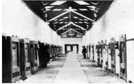
Imagen No 2. Estructura interna de un penal.
