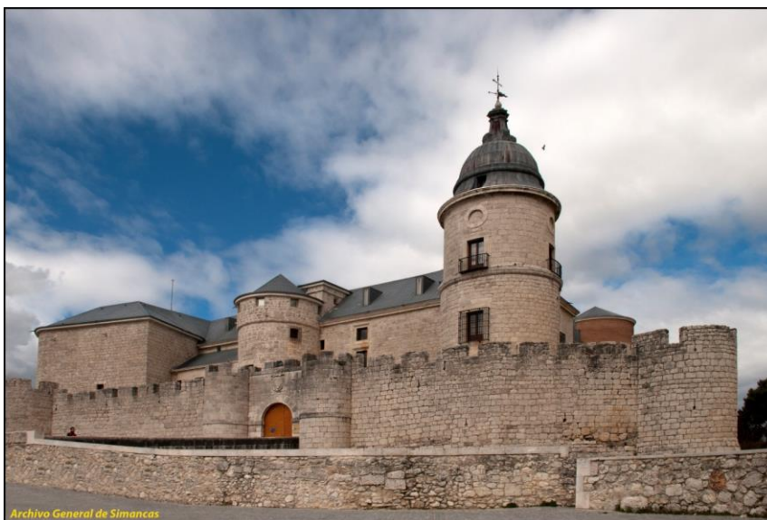
Archivo General de Simancas, Valladolid.
